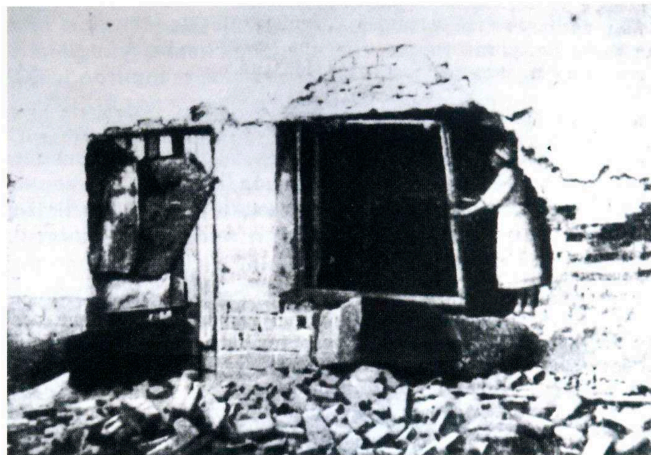
Повреждение здания госпитальной хирургической клиники в результате артиллерийского обстрела
